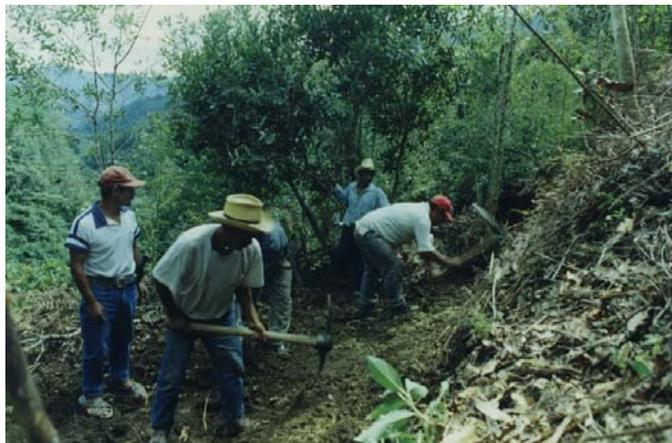
contorno del trazo y moviendo la tierra de su lugar para ir emparejando la superficie de la terraza. Al final se verificó que quedara horizontal y transversalmente a nivel la superficie, utilizando siempre el aparato "A"; además de hacerles, a manera de cuneta, una zanja de desagüe. 3 terrazas quedaron totalmente concluidas.
